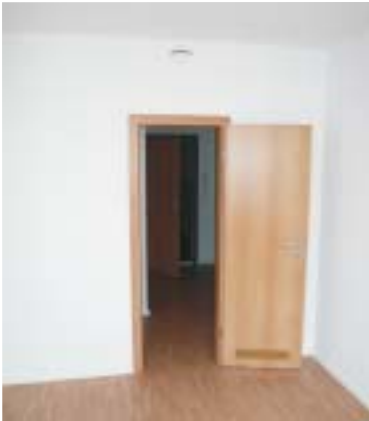
Leer - WE - Sanierung
